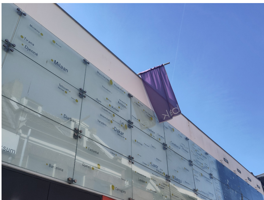
BAK-vlag op het dak
